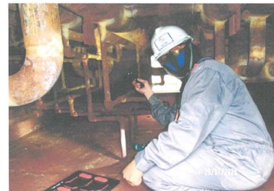
ตรวจสอบสภาพท่อน้ำทั่วๆไปภายในหม้อน้ำ ด้าน LP Part หม้อไอน้ำหมายเลข 1( HRSG-11 ) บริษัท ราชบุรีเวิลด์ โคเจนเนอเรชั่น จำกัด วันที่ 26 กรกฎาคม 2568
