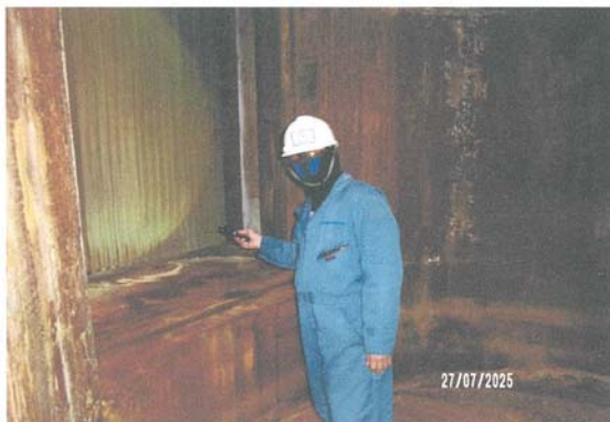
ตรวจสอบสภาพท่อน้ำทั่วๆไปภายในหม้อน้ำ ด้าน LP Part หม้อไอน้ำหมายเลข 2( HRSG-12 ) บริษัท ราชบุรีเวิลด์ โคเจนเนอเรชั่น จำกัด วันที่ 27 กรกฎาคม 2568
