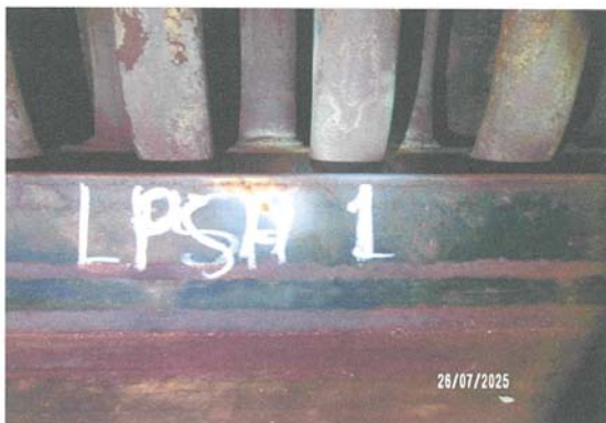
ตรวจสอบแนวเชื่อมทั่วๆไปภายในหม้อน้ำ LP Part หม้อไอน้ำหมายเลข 1( HRSG-11 ) บริษัท ราชบุรีเวิลด์ โคเจนเนอเรชั่น จำกัด วันที่ 26 กรกฎาคม 2568
