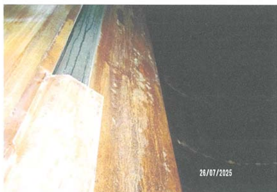
ตรวจสอบสภาพปล้องไอเสีย และ Expansion Joint สภาพปกติ หม้อไอ้หมายเลข 1( HRSG-11 ) บริษัท ราชบุรีเวิลด์ โคเจนเนอเรชั่น จำกัด วันที่ 26 กรกฎาคม 2568
